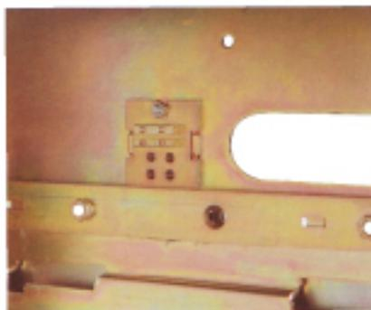
抽屉内置的识别装置，可防止将错误规格的抽出式断路器插入抽屉。
